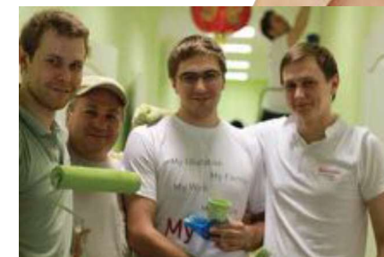
2011 – Командная работа банкиров из Ренессанс Капитала по покраске стен в «Большой Перемене»
